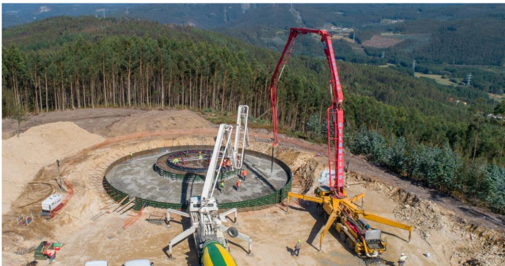
(1) Construcción parque eólico Miñón (A Coruña). Campa de acopio de materiales (2) Construcción parque eólico Ourol (Lugo). Cimentaciones
